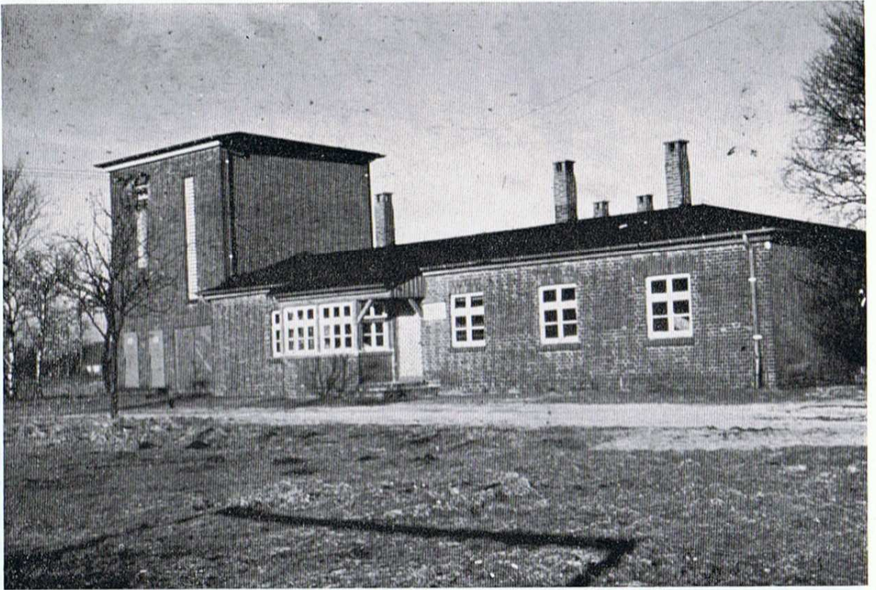
Büro der Lagerleitung beim Transformatorhaus
