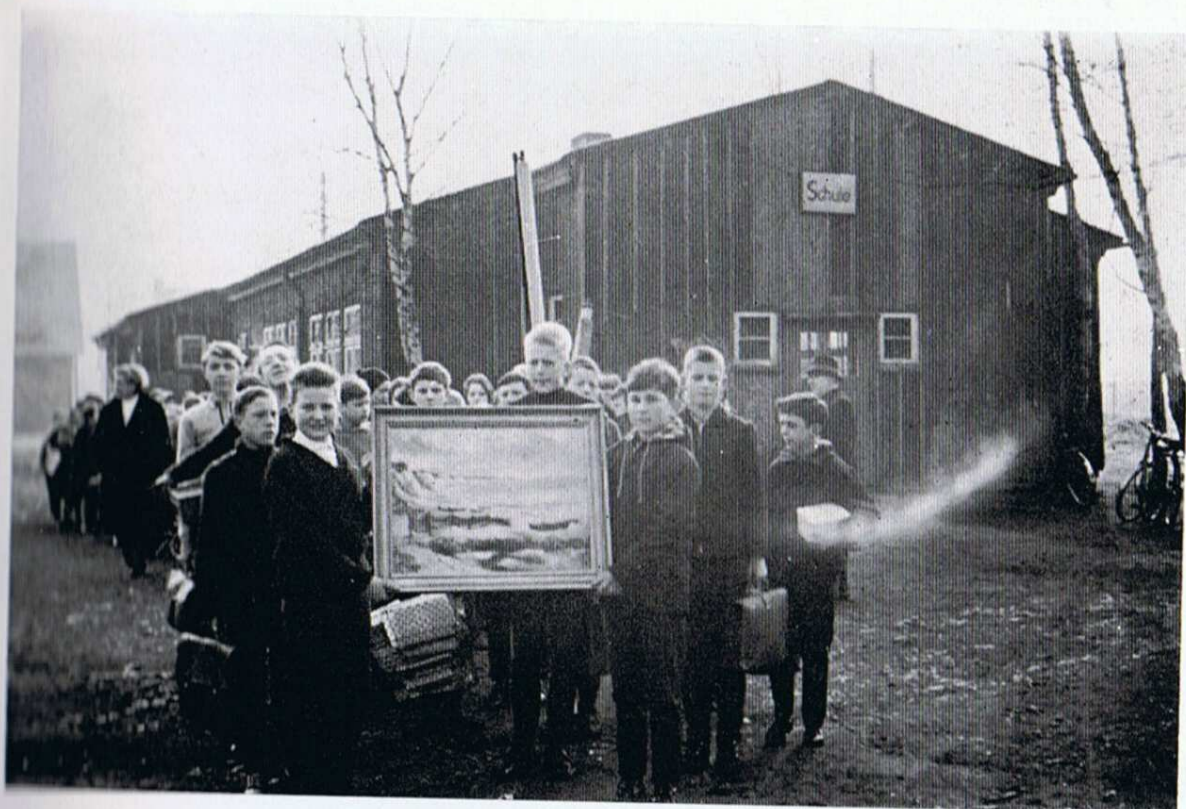
Endlich ein Fortschritt: Umzug der Schule aus der Schulbaracke in das neue Gebäude am 12. 3. 1964
